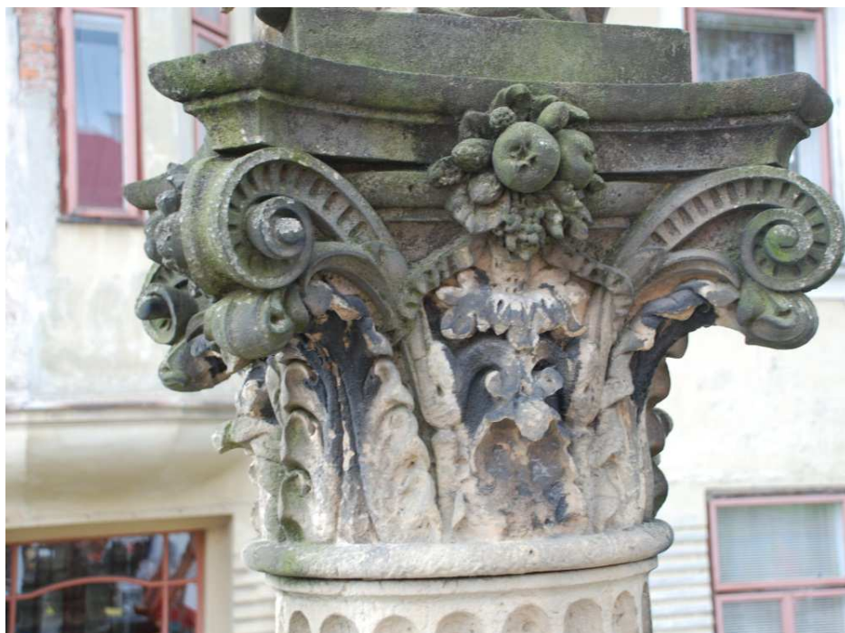
Hlavice sloupu. Černá vrstva neprodyšné krusty ve srážkových stínech.
