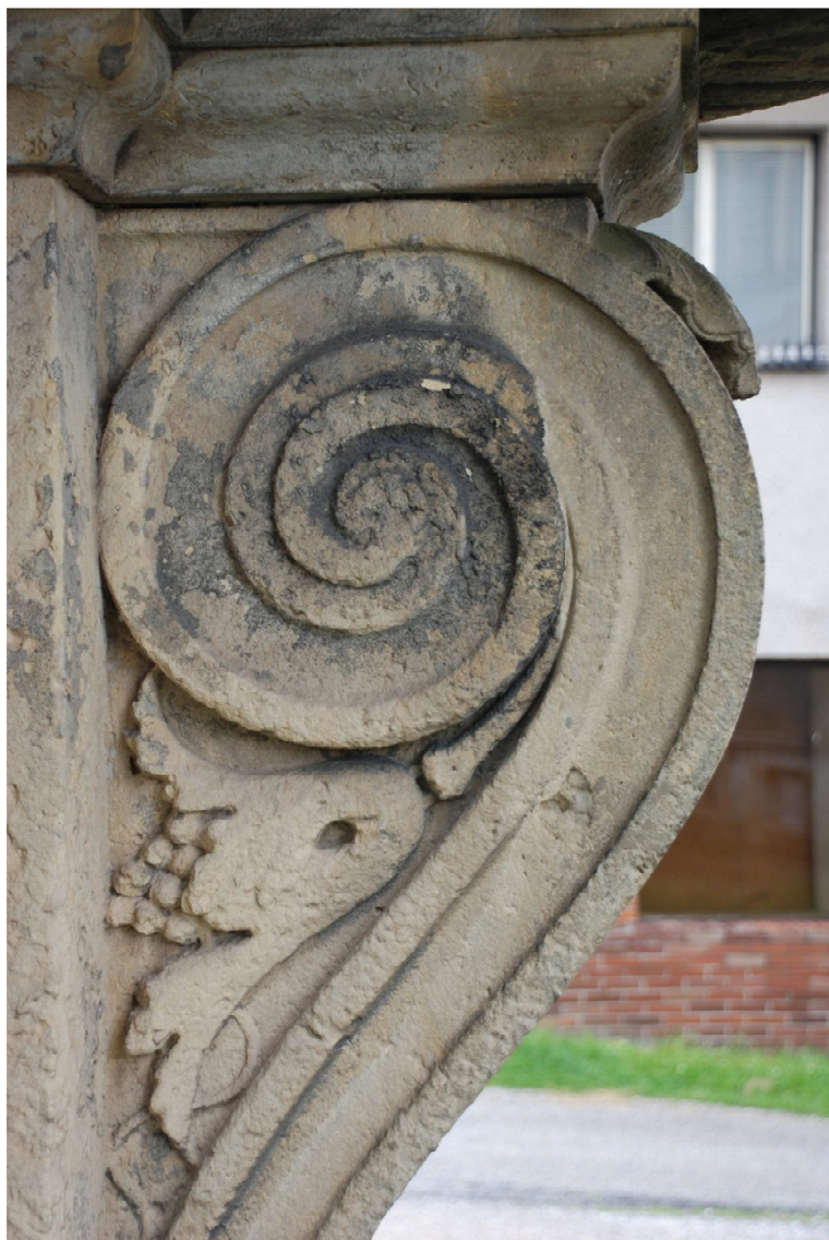
Voluta na podstavci. Neprodyšná vrstva krusty způsobuje zánik povrchové modelace.
