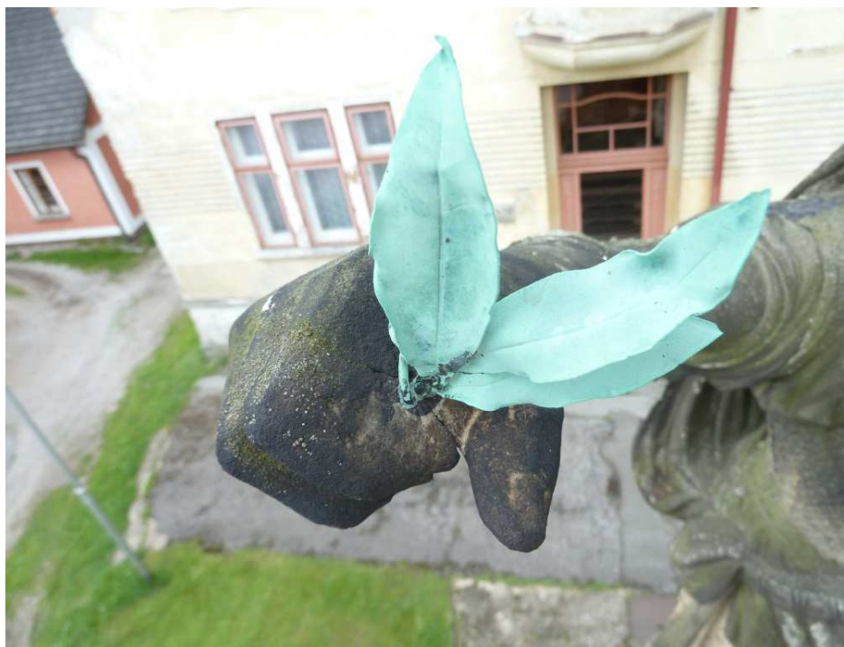
Socha Spravedlnosti. Fragment měděné ratolesti v pravé ruce. Prasklina v kameni, způsobena tlakem zatemňovaného olova při instalaci atributu.
