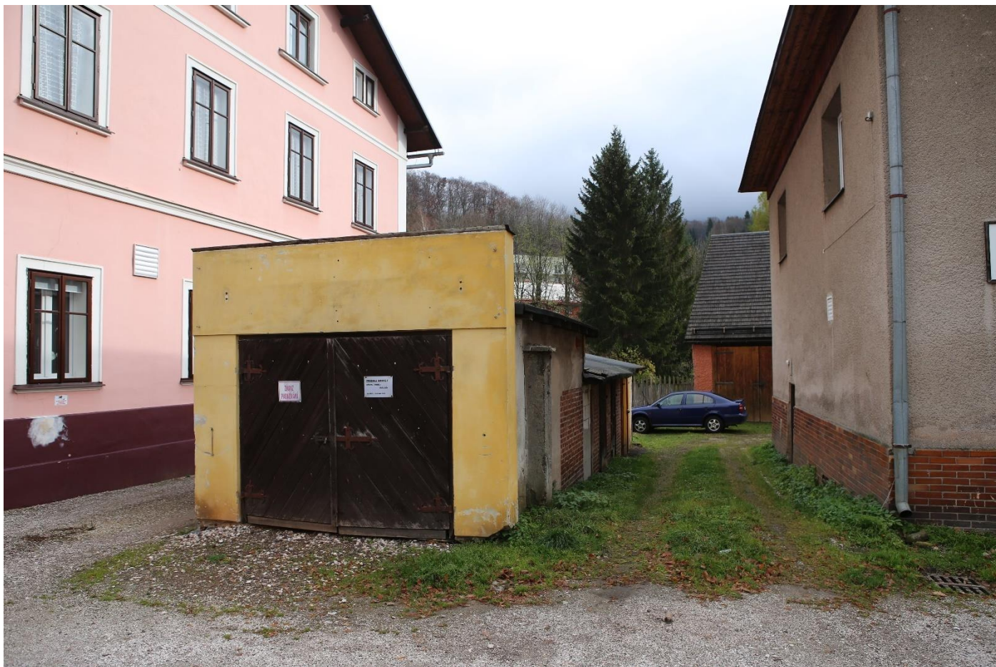
Obr.1 – Stav objektu garáže a skladů
